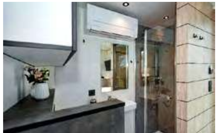
Kompakte Wandgeräte vom Typ MSZ-AP in der Hyper Heating Ausführung beheizen die Mikrozimmer des Roatel-Container Mikrohotel-Konzept
